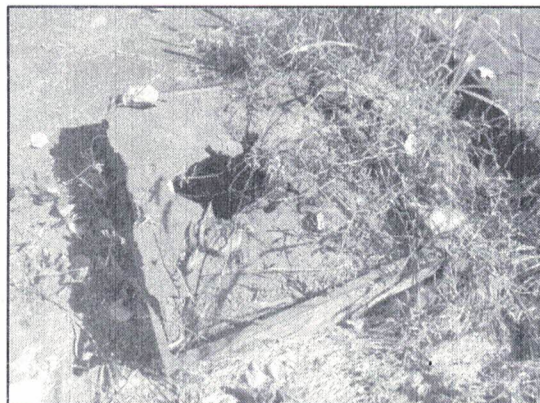
Figura 30 – Detalhe da tampa da fossa séptica
