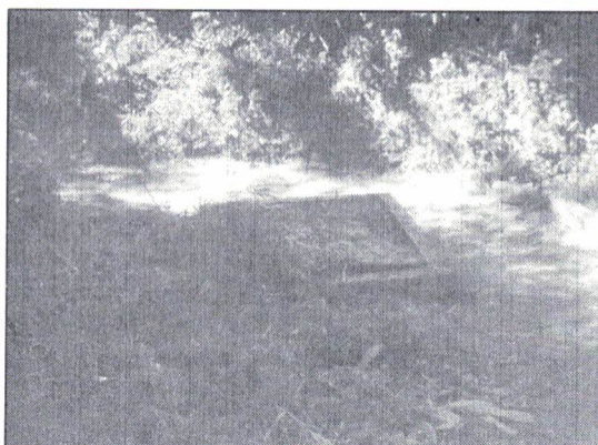
Figura 18 – Caixa de captação da nascente Carrijo
